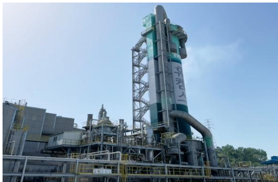
[ 초안 공장 미세먼지 제거 ]
